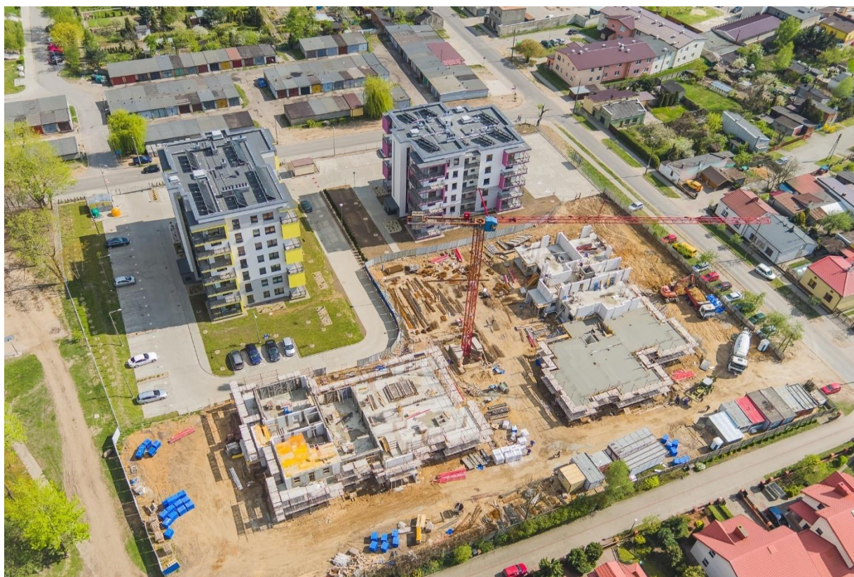
Zdjęcie 8. Osiedle „Wilcza Eska” w Kutnie w trakcie budowy
