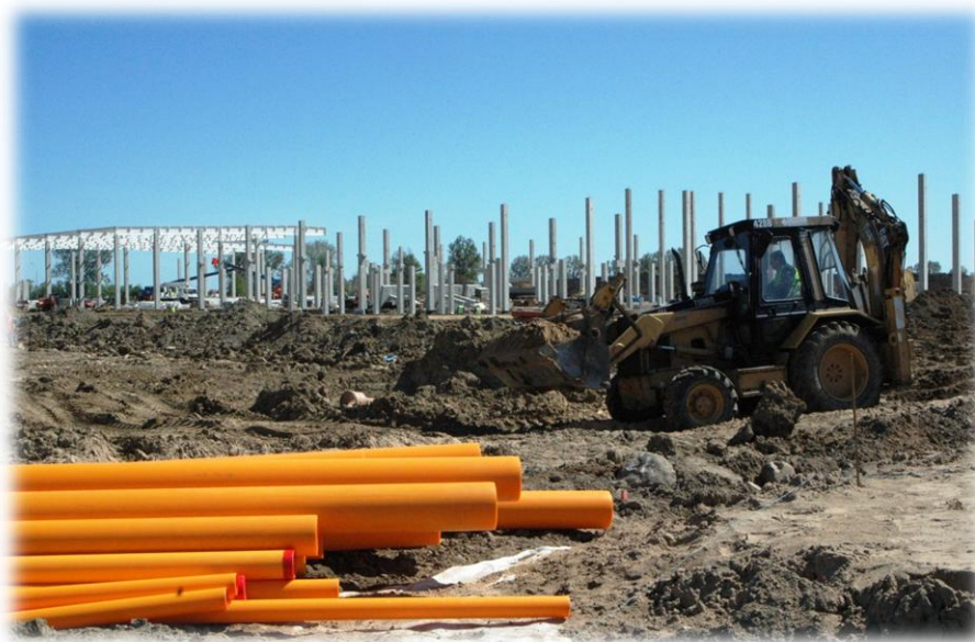
Zdjęcie 6. Budowa fabryki w Kutnowskim Parku Agro-Przemysłowym
