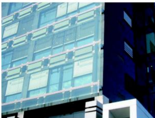
Przykład ekranu akustycznego zastosowanego na elewacji budynku Źródło: Bęben D., Hałas wokół szlaków transportowych , „Drogownictwo: 9/2010
